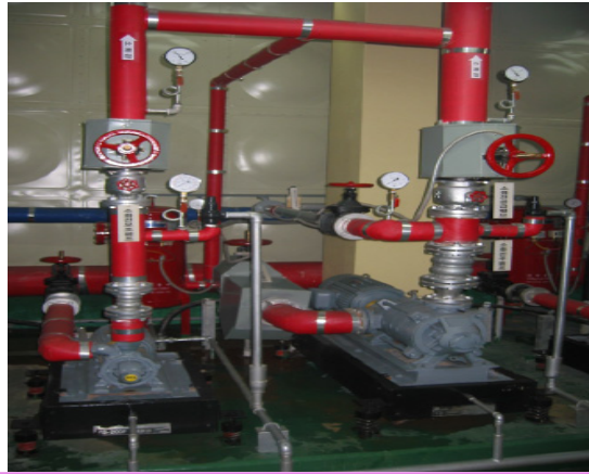
주펌프 및 충압펌프 설치 예
