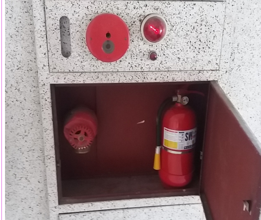
방수구함 내부 방수구 설치 예
