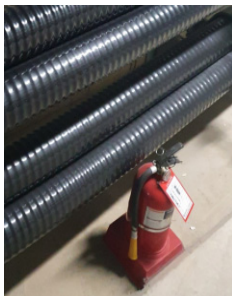
바닥에 받침대를 설치
